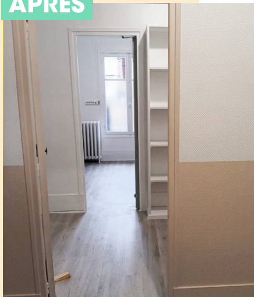
Travaux dans les écoles
