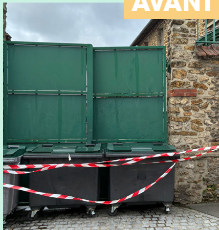
Réparation du mobilier urbain
